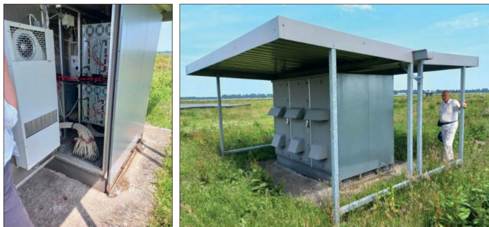
Рис. 6. LOFAR-кабінет — цифровий блок фазування та збору інформації секції LOFAR
