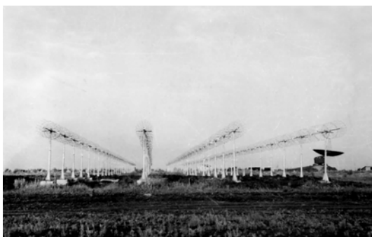
Рис. 2. Фотография восточной 128-элементной решетки для наблюдений в диапазоне частот 20 ÷ 40 МГц [28]
