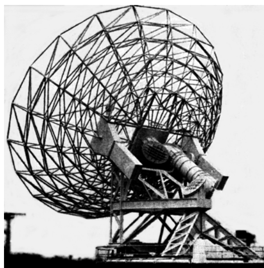
Рис. 25. Лучеводная система питания двухзеркальной антенны наземной станции спутниковой связи. (Репродукция из работы [117])
